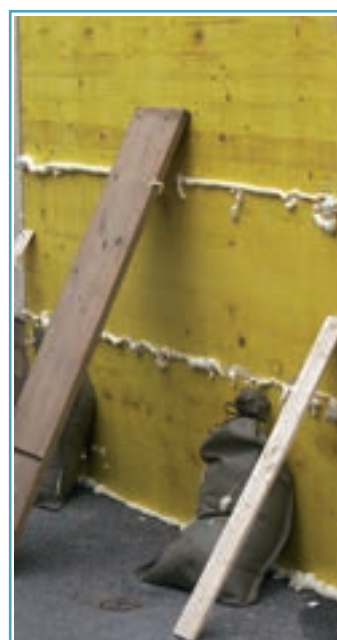
Behelfsmäßiger Gebäudeschutz mit PU-Schaum (Montageschaum) und Doka-Platten
